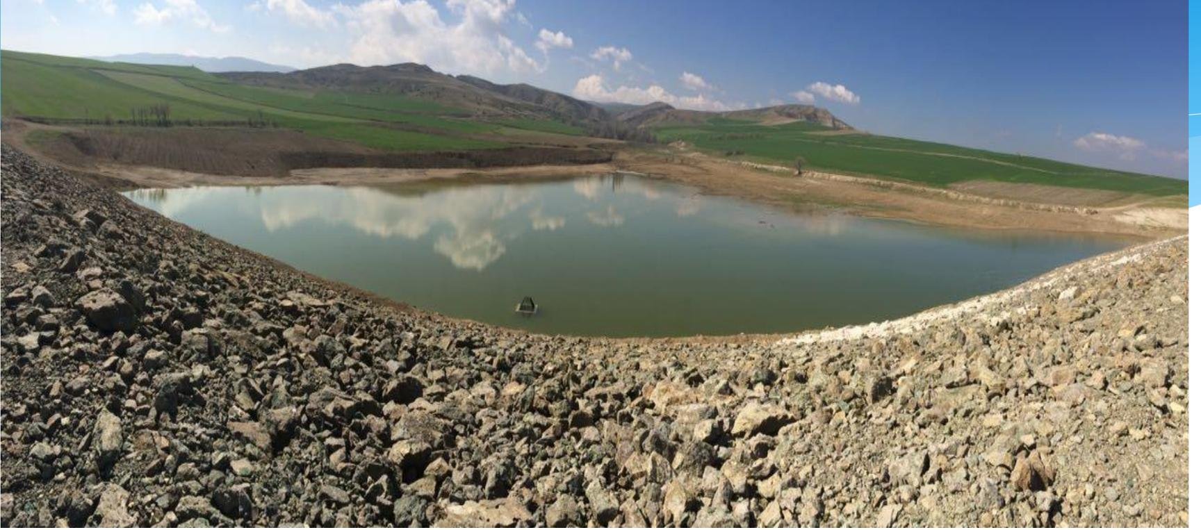
Yapımı 1965 yılında Mülga Topraksu tarafından gerçekleştirilen Merzifon Karşıyaka Göleti zamanla malzeme dolmuş depolama hacmi azalmıştır. 2015 yılında içi boşaltılmış, gövde yüksekliği artırılmış depolama hacmi artmıştır. Ayrıca Ana Dereye ilaveten Gümürdeyen Mevkiinden Gölete su derive edilmiştir. Son haliyle gölet 706.000m<sup>3</sup> depolama hacmine sahip olup; 375 Ha alanda sulama yapmaktadır.
